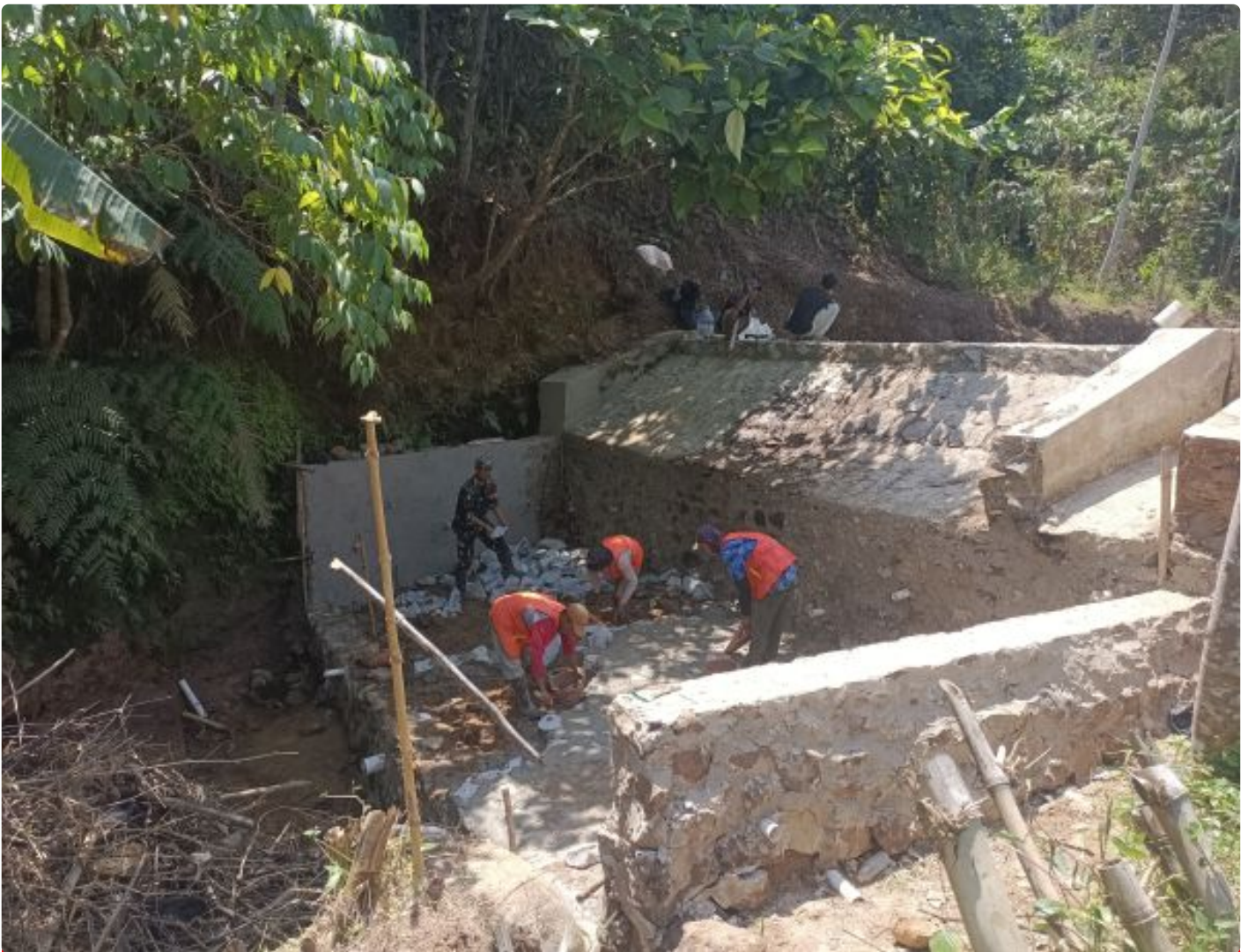
Babinsa tinjau pembangunan Bendung dan Irigasi
